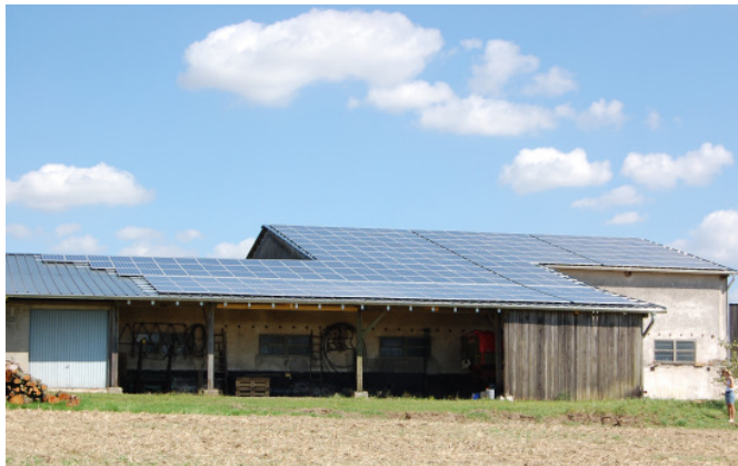
Neue Photovoltaikanlage auf dem Scheunendach des Birkenhofs in Roes
